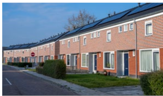
Bedum 84 woningen verduurzamen en renovatie
